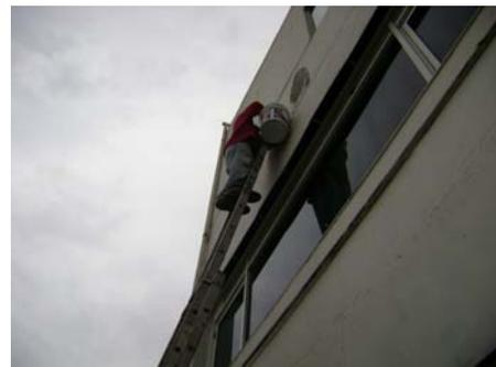
20) MANTENIMIENTO DE SELLADO EXTERIOR EN VENTANAS DEL EDIFICIO DEL CONSEJO DE LA JUDICATURA, PARA EVITAR FILTRACIONES MAYORES DE AGUA DE LLUVIA.
