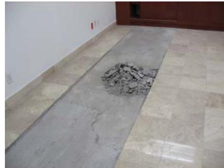
22).- CAMBIO DE PISO NUEVO TIPO MÁRMOL, DEBIDO A QUE SE BOTÓ EL EXISTENTE, TENIÉNDOSE QUE REALIZAR TRABAJOS URGENTES EN JIUTEPEC, MORELOS. (ACOMODAMIENTO DE LA ESTRUCTURA Y PISO)
